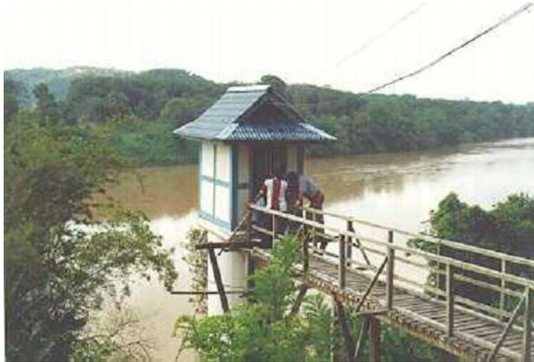
Gambar A4.8: Pusat Telemetry Ketinggian Air yang dipasang di Sungai Kuantan (DID Malaysia)
