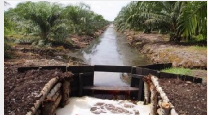
Rajah 4: Struktur kawalan air tidak perlu struktur yang mahal dan boleh dibina dengan beg kayu atau pasir
