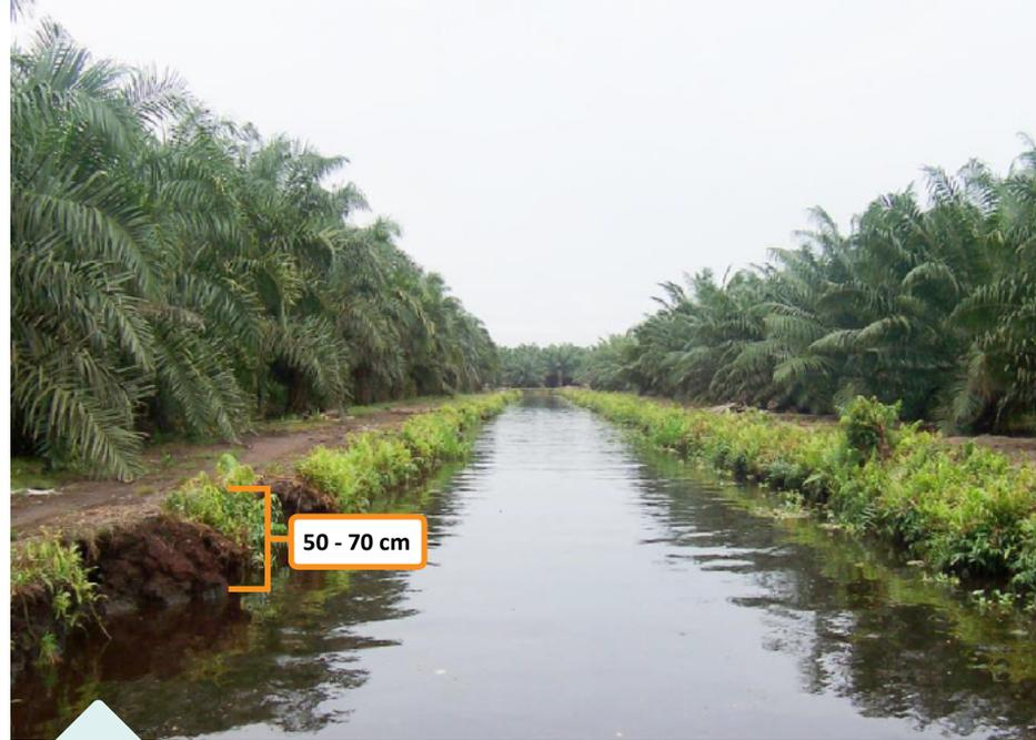
Gambar 5: Air yang diukur di saluran pengumpul harus berkisar antara 50cm – 70cm. (Sumber gambar: Global Environment Centre, GEC)
